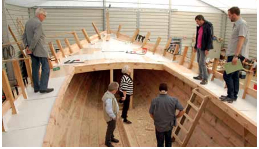
Abb. 8: Blick in den Laderaum von „Laurons II“.
