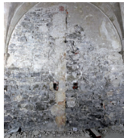
Abb. 4: Gebäudeecke aus Sandsteinquadern in der Südwand des Kreuzgangs (Foto: Hartwig Wachsmann).
