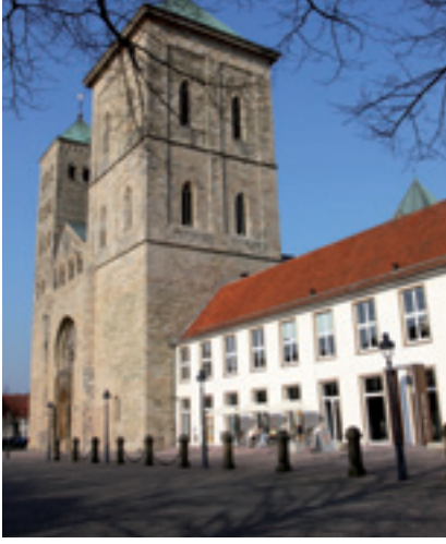
Abb. 2: Blick auf den Dom nach Fertigstellung der Sanierungsarbeiten im Frühjahr 2009 (Foto: Ellinor Fischer).
