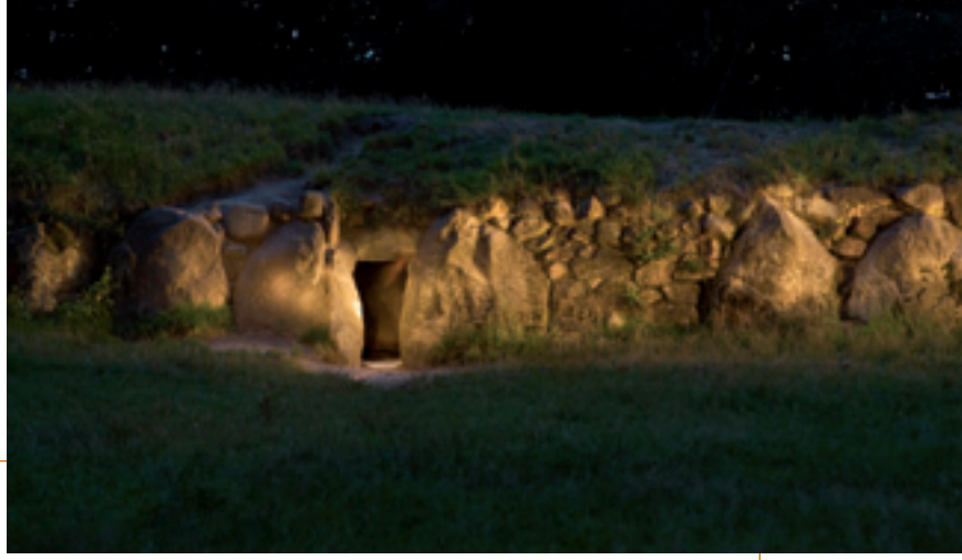
Abb. 1: Blick auf den nach Süden weisenden Eingangsbereich der rekonstruierten Anlage „Großsteingrab I von Kleinenkneten“ (Foto: Axel Hartmann).
